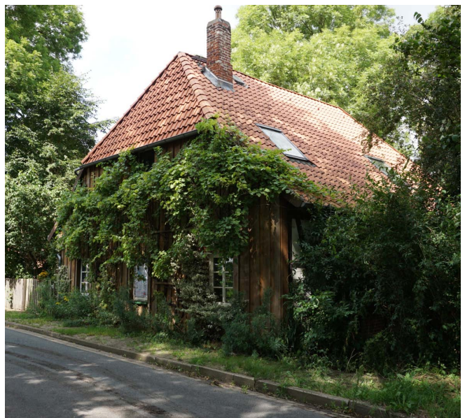
Abb. 82: Boden-Deckelschalung aus Holz
