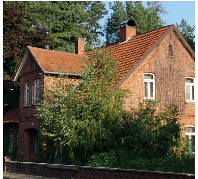
Abb. 76: Gebäude mit Satteldach und Zwerchhaus
