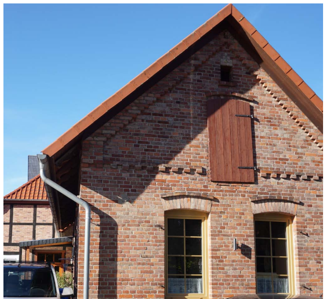
Abb. 93: Zu Wohnraum ungenutztes ehemaliges landwirtschaftliches Gebäude
