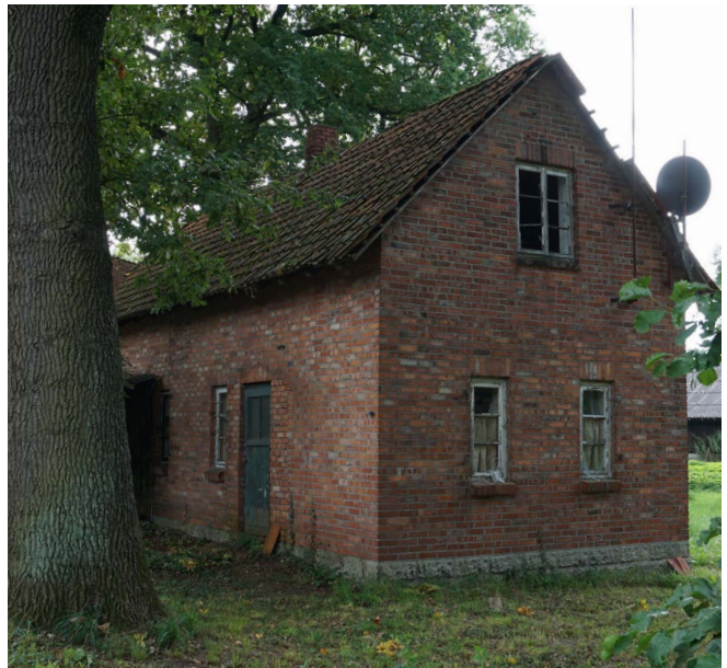
Abb. 91: Untergenutztes landwirtschaftliches Nebengebäude
