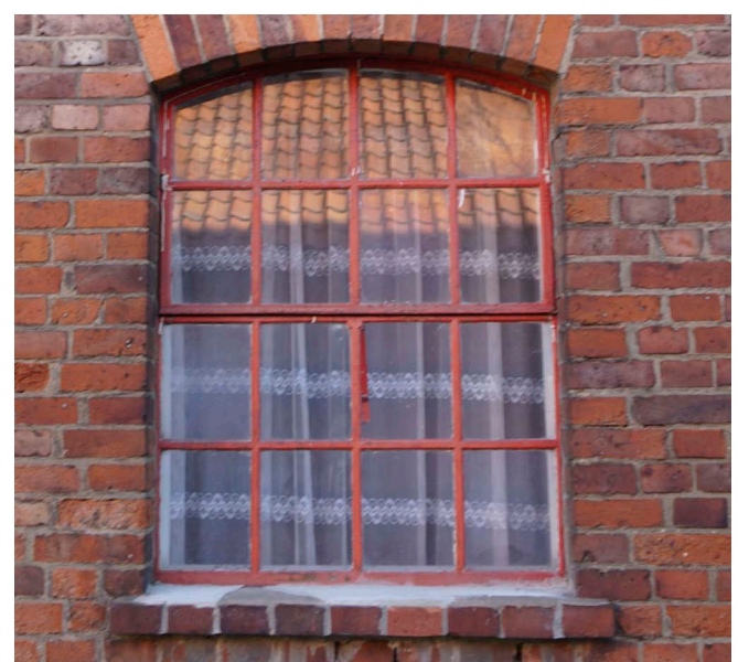
Abb. 87: Metallenes Fenster mit Segmentbogen
