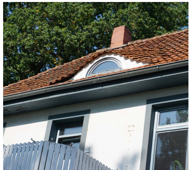
Abb. 77: Dach mit Fledermausgaube
