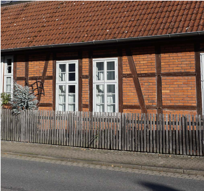
Abb. 84: Doppelte Holzfenster mit Kämpfer
