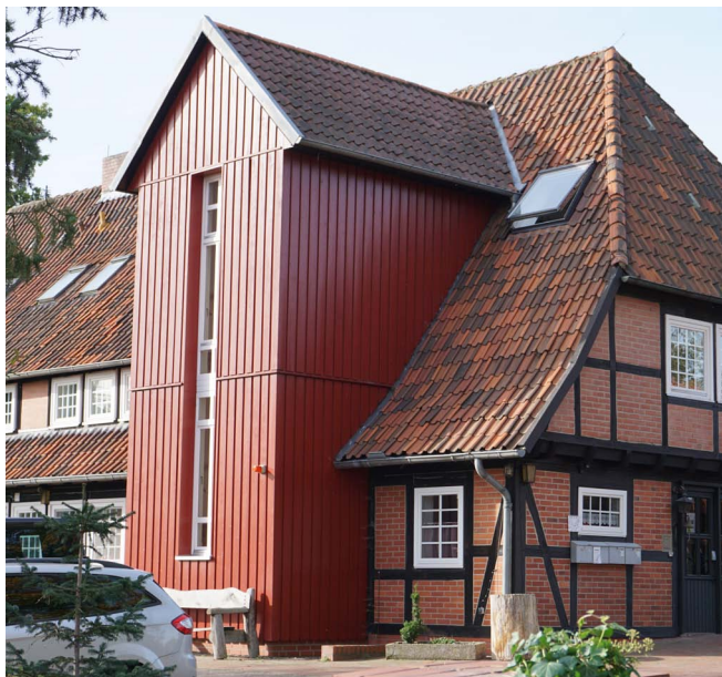
Abb. 79: Gebäude mit ausgemauertem Fachwerk und ortsbildtypischem Anbau mit Holzfassade
