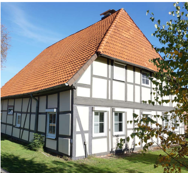
Abb. 75: Wohnhaus mit Krüppelwalmdach und Hohlfalzziegeln
