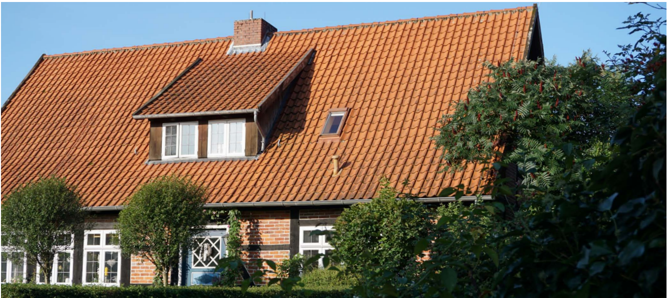
Abb. 73: Dacheindeckung mit Linkskrempen | Schleppgaube
